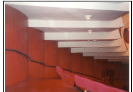
Abb. 2. Rückwandverkleidung zur Vermeidung von Brennpunkten; Renovierung Teatro Regio, Turin, 1997
