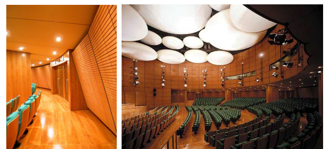
Abbildung 18: Auditorium di Lodi: Maßnahmen gegen die Brennpunktbildung links: geneigte Rückwand; rechts: diffus reflektierende Wände und Deckenelemente
