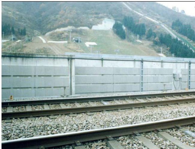
Abbildung 5: Lärmschutzwall: Die Akustikpaneele sind schon seit Jahren als Lärmschutzwand beim Shin-kansen-Zug (Japan) im Einsatz. Die Witterung tut der Absorptionsfähigkeit keinen Abbruch.
