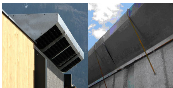
Abbildung 1: SSI-Aufsatzelemente unten offen (links) und modifiziert mit geschlossenen Röhren (rechts)
