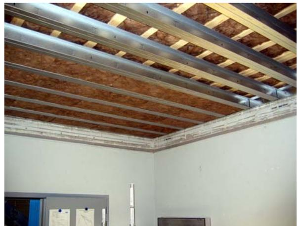
**Abbildung 2:** Versuchsholzbalkendecke mit freitragender Unterdecke aus Doppelprofilen CW 125x50x06.
