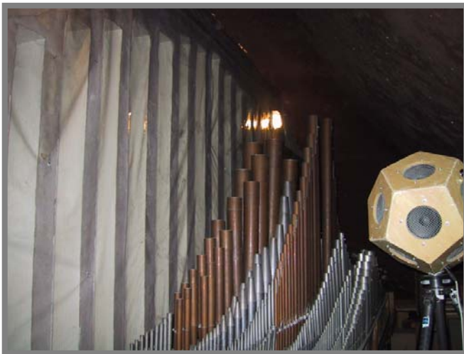
Abbildung 1: Aufstellung des Messlautsprechers im Kronpositiv hinter Betongitter-Prospekt und PE-Folie
