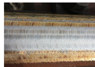
Konventionelles Profilschleifen bei Göschenen u. Kerzers
