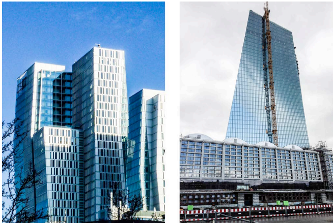
Abbildung 1: Hochhäuser mit nach unten geneigten Fassaden, links : Nexttower, Zeil Hoch Vier, Frankfurt am Main, Fertigstellung 2009, Höhe 136 m, rechts: Hochhaus EZB, Frankfurt am Main, Fertigstellung 2015, Höhe 185 m
