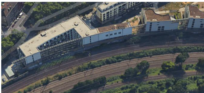
Abbildung 2: Transparente Lärmschutzwände beim Bauprojekt BDP Volksgarten-Plus, Köln, Eifelplatz, Blick von der Bahnseite (Trasse Köln-Bonn) http://www.bpd-koeln.de/volksgarten-plus Quelle: Google Earth.
