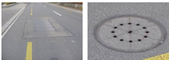
Abbildung 3: Beispiele für einen eckigen Plattendeckel auf einem lärmarmen Belag (links) und einen runden Schachtdeckel auf einem herkömmlichen Belag (rechts).
