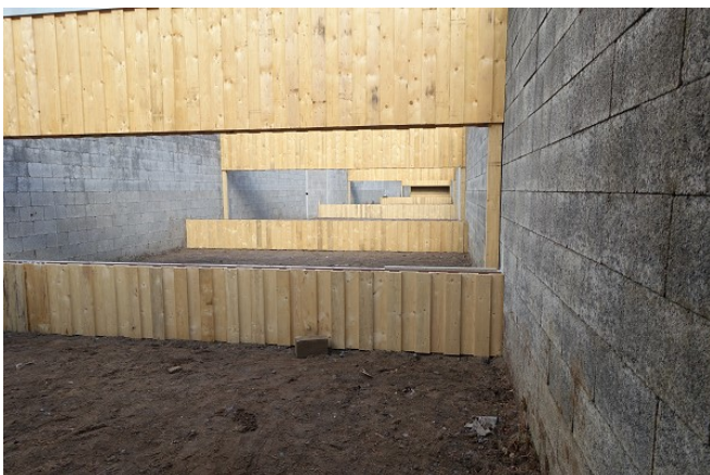
Abbildung 6: Boden-/Tiefblenden 100-m-Schießstand.
