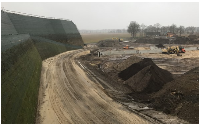
Abbildung 1: Erdwall (im Bau) für mehrere Trap- und Skeet-Schießstände für 100-Prozent-Schrotrückhalt
