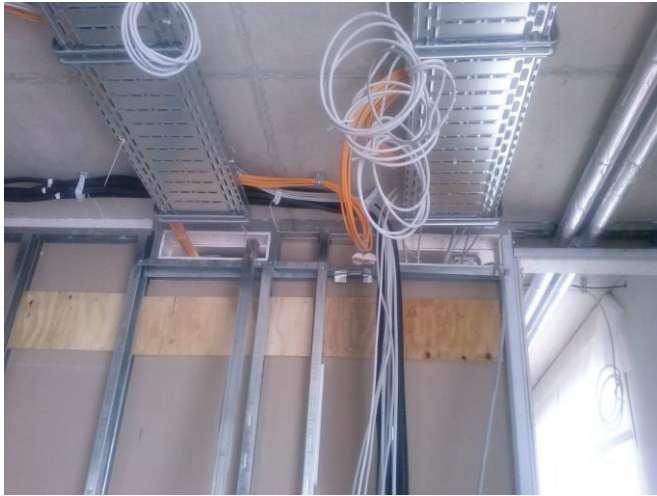
Abbildung 4: Klassenraumtrennwand im Bau
