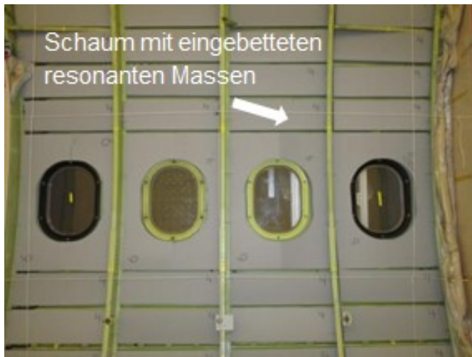
Abbildung 2: A300 Seitenwandstruktur im Transmissionsprüfstand bei Airbus; Schaum mit eingebetteten resonanten Massen (grau).
