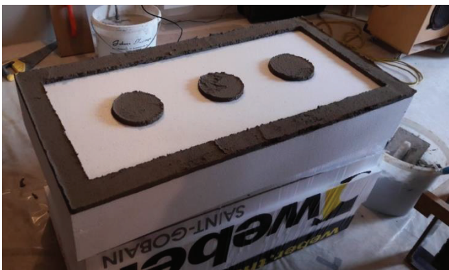
Abbildung 3: Kleberflächenanteil auf der EPS-F Platte
