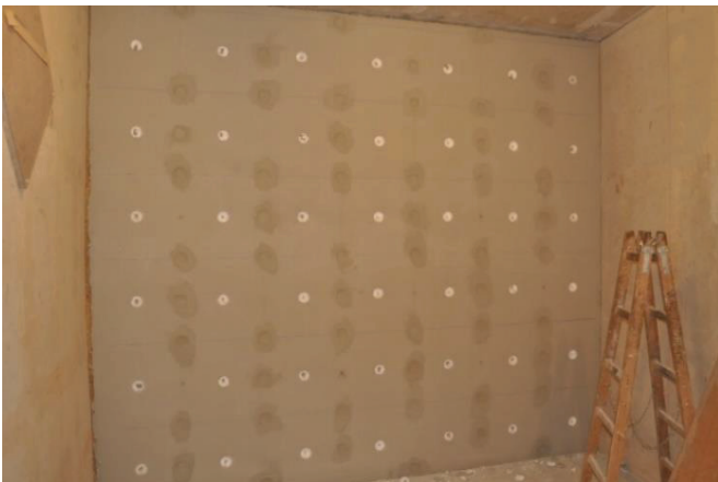
Abbildung 4: Eingebauter Prüfkörper mit bereits verspachtelten und noch unverspachtelten Öffnungen im Putz zur Montage der Dübel
