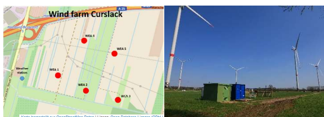
Abbildung 1: links: Lageplan des Windparks Curslack; rechts: die fünf WEA des Windparks Curslack mit der untersuchten Anlage WEA1 vorne links
