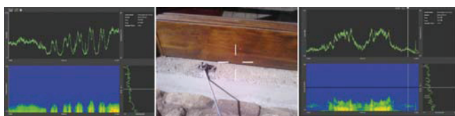
Abbildung 4: Wiederholtes „Überstreichen“ einer undichten Stelle (links) und das Vorgehen an einer ausgedehnteren undichten Stelle (rechts). Die Prüfung erfolgte hier mit der breitbandigen Rauschquelle. Die Ergebnisdarstellung zeigt den mittleren Schallpegel (20-100 kHz, grüner oberer Schrieb) und das zeitsynchron berechnete Spektrogramm (Zeit-Spektrum).
