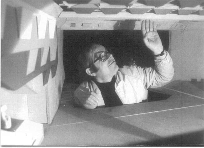
Abb. 2 Architekt Enes betrachtet die Deckengestaltung im Modell der Stadthalle Oberursel 1983. Oberhalb seines Kopfes sind die Auslaßöffnungen für die Lautsprecher zu erkennen. Sie sind später nicht sichtbar.
