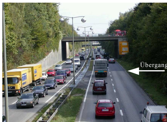
Abbildung 1: B 17 in Augsburg mit Übergang zum offenporigen Asphalt
