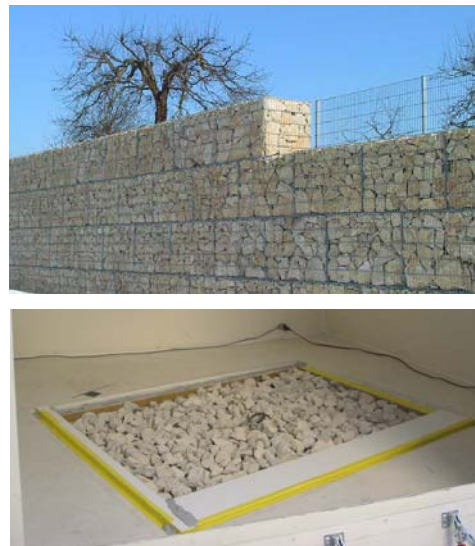
Abbildung 5: oben: Gabionen aus Steinschüttungen ( www.frankenschotter.de ), unten: Schüttung in Hallkabine
