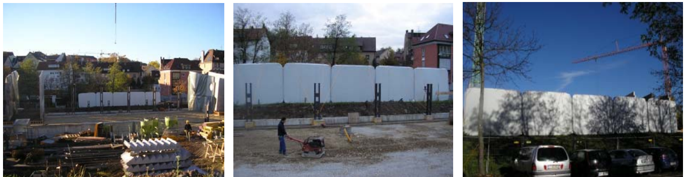
Abbildung 3: Bilder vom Baustelleneinsatz aufblasbarer Abschirmungen an der Baustelle Leuze-Bad Stuttgart (Parkhaus-Neubau): Blick über die Baustelle mit den aufgestellten Elementen (links), Lärmschutz der anliegenden Wohnbebauung bei Bodenverdichtungsarbeiten mit einer Rüttelplatte (mitte) und Ansicht der Abschirmung aus Richtung der Immissionsorte (rechts). Jedes der fünf Elemente hatte die Abmessungen 4,2 m x 3,4 m (B x H). Der Schirm bestand aus zwei Membranlagen ( D = 1,1 \text{ mm} , m'' = 1,4 \text{ kg/m}^2 je Lage), die im aufgeblasenen Zustand durch flexible Kunststoffstege auf 15 cm Distanz gehalten wurden.
