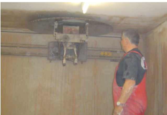
Abbildung 1: Nachträgliches Abtrennen der Hochlochziegelwand vom Prüfstand mittels einer Mauerwerkssäge.
