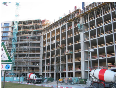
Abbildung 3: Gebäude in Skelettbauweise
