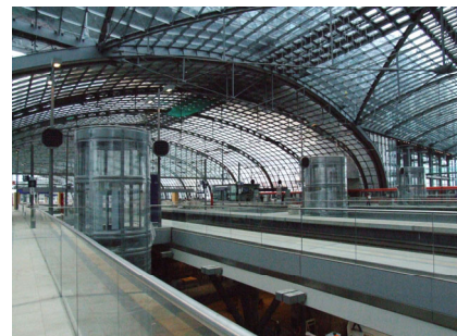
Abb. 5: Ansicht West-Ost-Bahnsteighalle, Berlin Hbf
