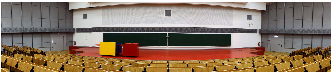
Abbildung 1 Bühnenbereich fertiger Hörsaal H 104 der TU Berlin mit umlaufendem WFS-Lautsprecherarray
