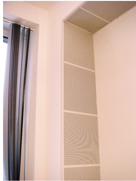
Abbildung 4: An Kanten-Absorbern , die sich bereits in Studios und Unterrichtsräumen bewährt haben, soll zunächst die hygienische Aufwertung getestet werden.
