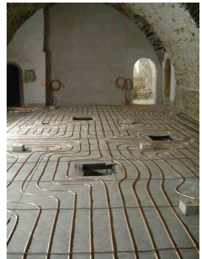
Abbildung 4 Verlegung eines Flächenstrahlers (waagrecht im Bild) auf Stahlbeton und Heizleitungen
