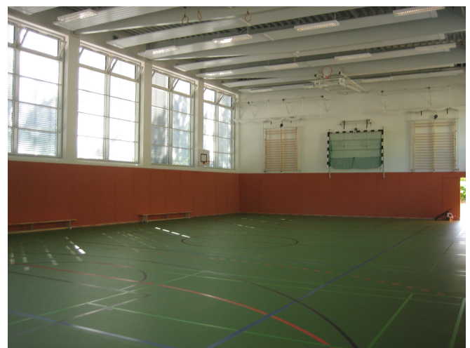
Abbildung 2: 1-Feld-Sporthalle mit senkrechtem textilen Prallschutz (Halle 1)
