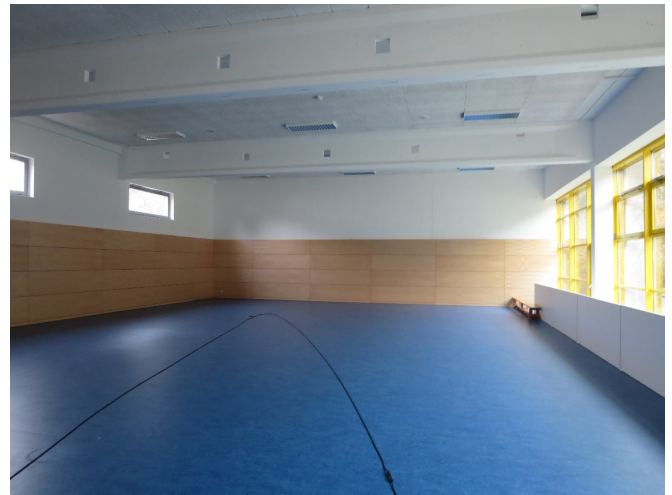
Abbildung 8: 1-Feld-Sporthalle mit geneigtem, schallharten Prallschutz an einer Längswand und einer Stirnwand (Halle 4)
