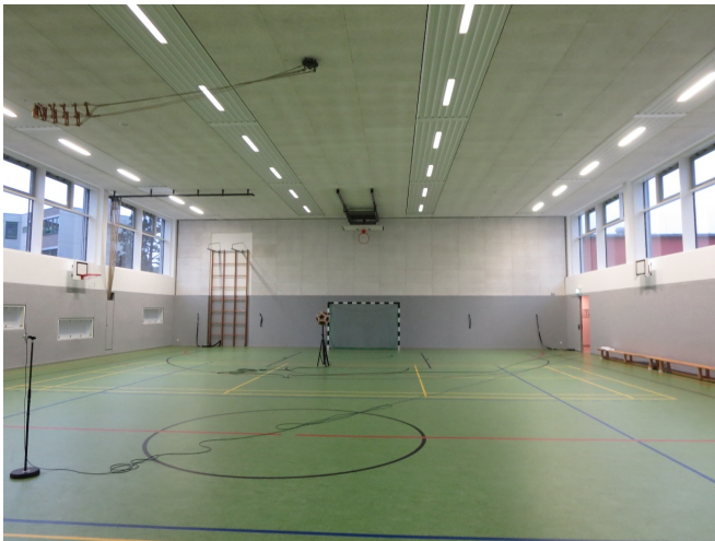
Abbildung 6: 1-Feld-Sporthalle mit geneigtem textilen Prallschutz vor den Stirnwänden (Halle 3)
