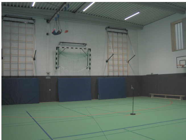
Abbildung 4: 1-Feld-Sporthalle mit geneigtem textilen Prallschutz vor den Stirnwänden (Halle 2)
