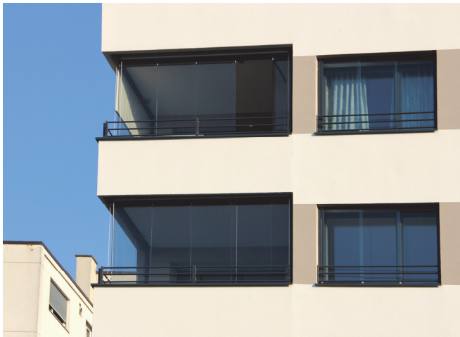
Abbildung 1: Verglaste Loggia und schiebbare Glaselemente vor den Fenstern als Lärmschutzmassnahme entlang einer stark befahrenen Strasse.
