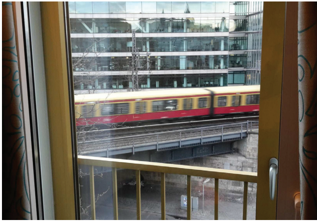
Foto 1: Blick aus einem Hotelzimmer auf eine unmittelbar am Gebäude verkehrende S-Bahn. Der Schallschutz wird hier über eine Kastenfensterkonstruktion und eine zentrale Lüftungsanlage gewährleistet. Solche baulichen Maßnahmen sind schalltechnisch sehr wirksam, verursachen aber auch Kosten. Daher muss geklärt werden, was erforderlich und sachgerecht ist.
