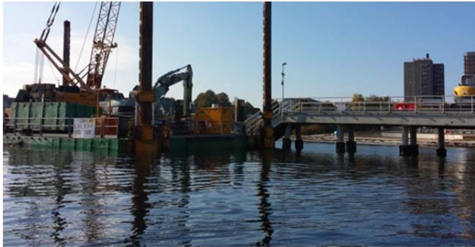
Abbildung 8: Hafen-Baustelle in Kiel-Schilksee
