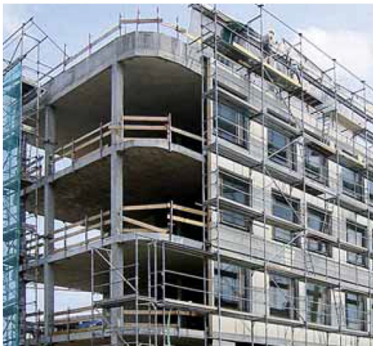
Abbildung 1: Beispiel eines Stahlbetonhochbaus mit Holzständeraußenwänden, aus [4]
