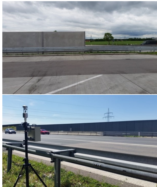
Abbildung 2: Messsituation an der Lärmschutzwand (oben) bzw. mit Belagswechsel (unten).
