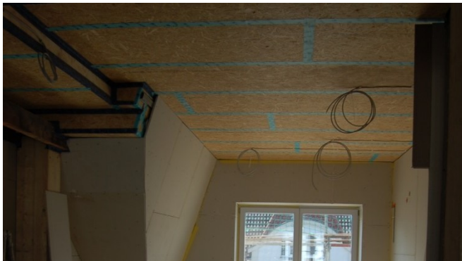
Abbildung 2: Abkleben von Stoßstellen (blaues Luftdichtigkeitsklebeband)
