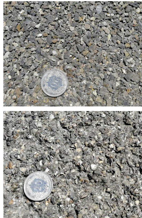
Abbildung 5: Belagsfotos, Oben: Direkt vor Abzweigung Analysequerschnitt 1, Unten: Bei der Abzweigung Analysequerschnitt 1 (Abbiegen der LKW's)
