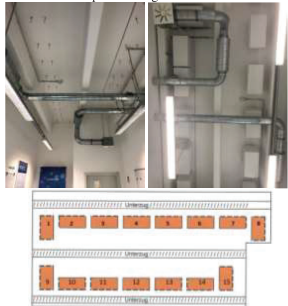
Abb. 10: Installation von BAT nahe den Beton-Unterzügen in einem kleinen Besprechungsraum
