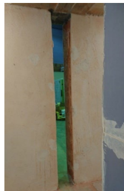
Abbildung 2: Ansicht der Aussparung für die nachträglich eingebaute Stütze.
