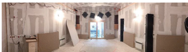
Abbildung 1: SR-Variante SRnorm: normatives Setup, welches auch für die Messungen nach EN ISO 10140 im Prüfstand verwendet wird
