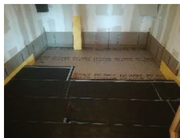
Abbildung 2: Einbringen der MW-Aufdachdämmung auf das Dachelement
