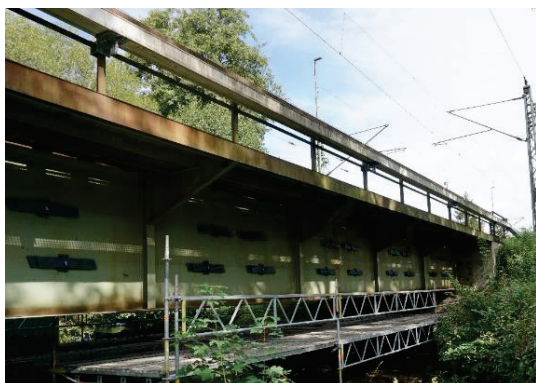
Abbildung 5: Eisenbahn-Stahlbrücke in Pressig, Bayern, (Frankenwaldbahn) ausgerüstet mit Brückendämpfern der Schrey & Veit GmbH (aus [10]).
