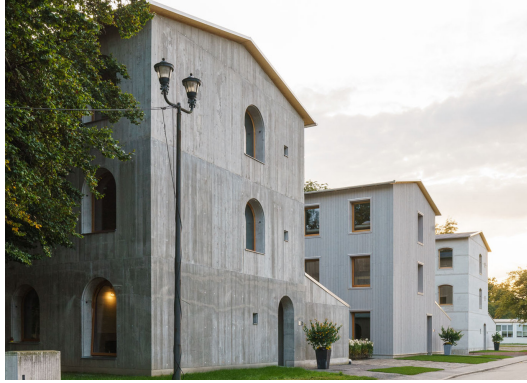
Abbildung 1: Die drei Forschungshäuser in den unterschiedlichen Bauweisen. V.l.n.r. Leichtbeton, Holz, Ziegel [1].
