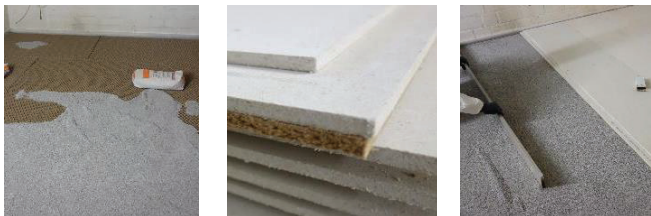
Bild 1: Aufbau auf der Holzbalkendecke
